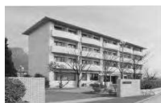
留学生宿舎（屋島地区）
